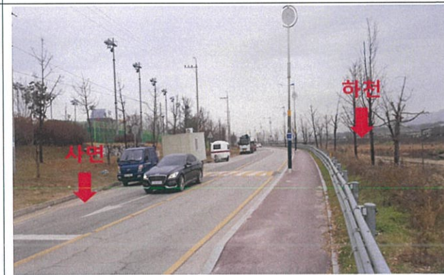
매립사면 복토 후 도로 이용
