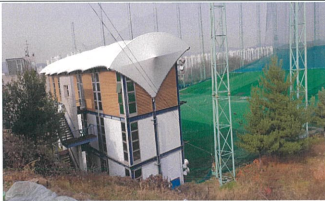
골프 연습장 내 조립형 건물 - 1
