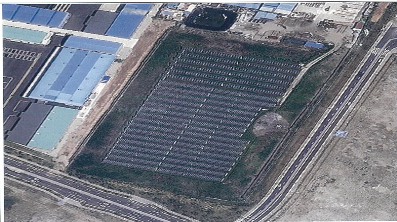
KC환경개발 1공구(태양광 발전시설)
