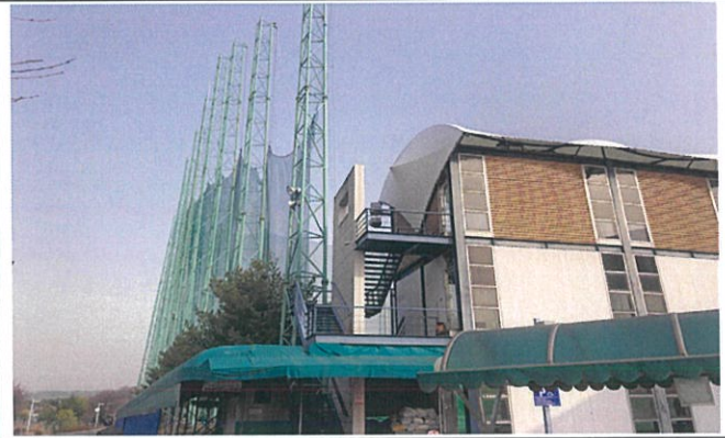
골프 연습장 내 조립형 건물 - 2
