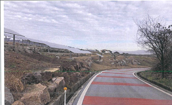
매립시설 내 도로
