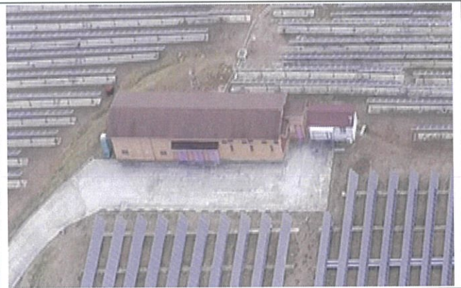
매립장 상부 전기발전시설
