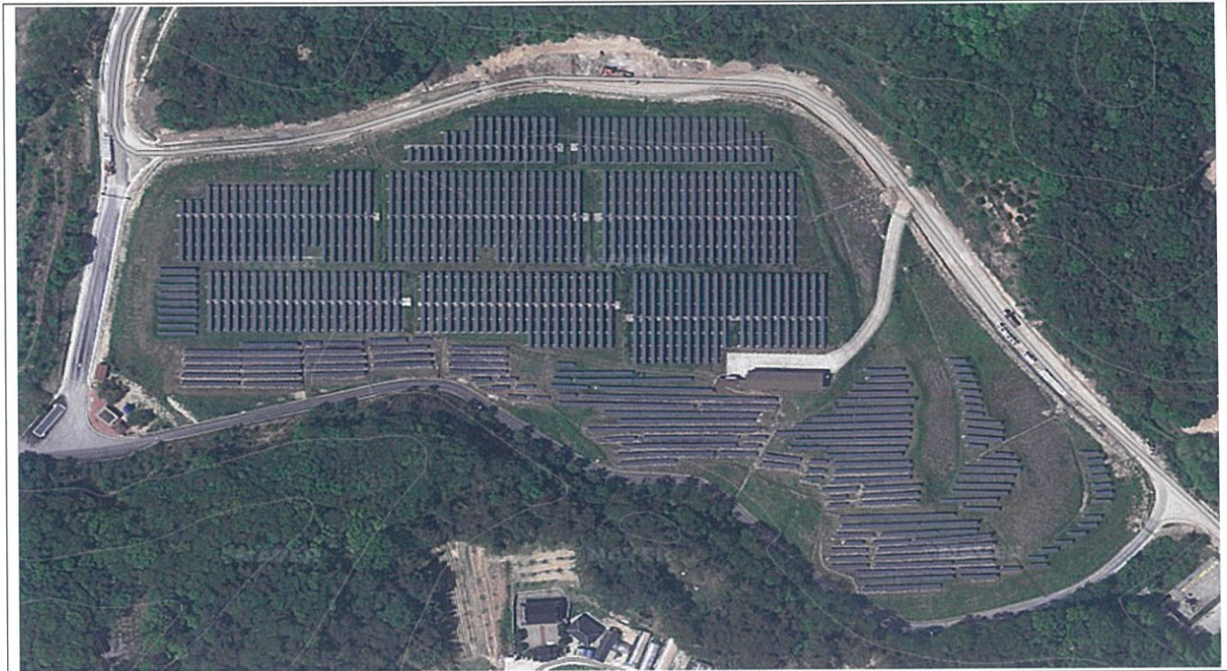
전주시 삼천동 매립지 상부(태양광 발전시설)
